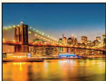
ENERO Puente de Manhattan, Nueva York
